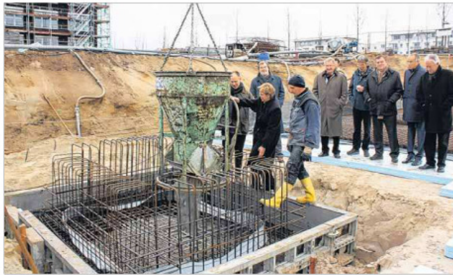
Christa Meyer, Vorstand für Krankenpflege und Patientenservice des UKSH, legt bei der feierlichen Grundsteinlegung für den Verwaltungsneubau selbst Hand an die Betonbombe. Foto: Julia Konerding
